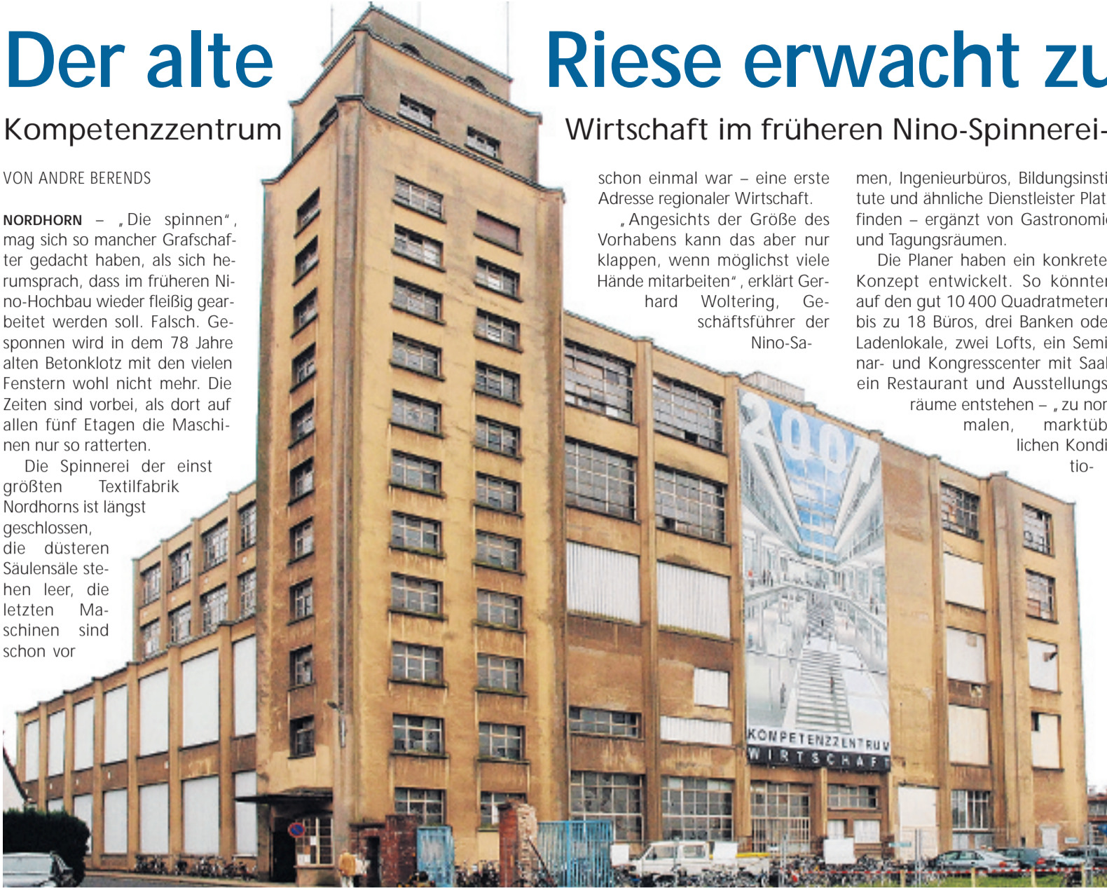
Das fünfstöckige Gebäude soll in den kommenden Monaten ein komplett neues Innenleben erhalten. Die Eröffnung ist für Mitte 2008 geplant. FOTOS: J. LÜKEN
